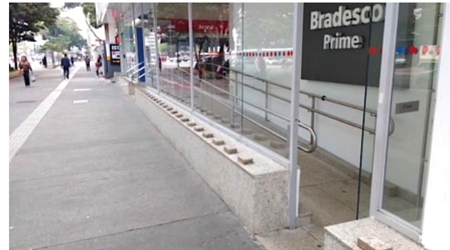
Imagem: Pequenos blocos de pedra instalados sobre mureta: esses elementos desencorajam o ato de se sentar; e possivelmente repelem também intencionalmente praticantes de skateboard , os “skatistas” (fachada de agência do Banco Bradesco). Ações como esta configuram a “hostilidade” percebida por Adriana S. Fontes (2013) e não colaboram para o desenvolvimento da civilidade, ou seja, não contribuem para a criação de espaços-civis. (Impedir: “proibido sentar”; repelir;). – Foto (32) do Quadrante 3/8 do Mapa de Estudo. Fonte: foto do autor, 2019.
